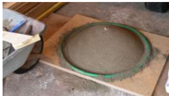
Sable tassé après premier « troussage »
