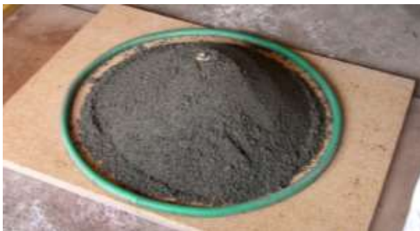
Mise en place du sable
