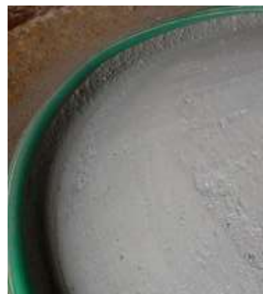
Coffrage prêt avec mortier lissé et quart de rond concave contre tuyau d'arrosage disposé en anneau.
