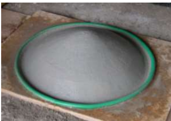
Coffrage prêt avec mortier lissé et quart de rond concave contre tuyau d'arrosage disposé en anneau.
